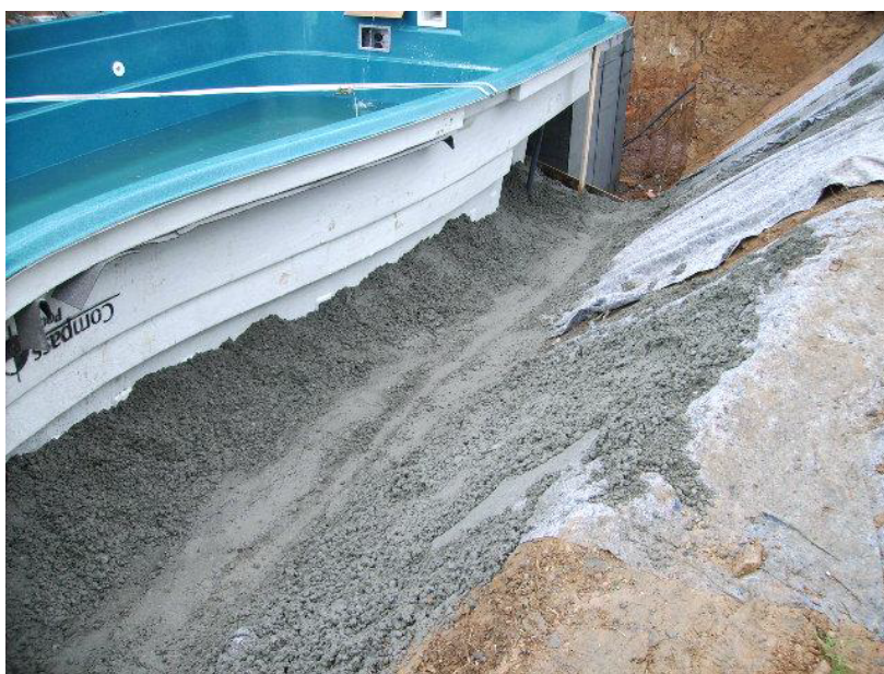
Obsyp tělesa bazénu suchým betonem
